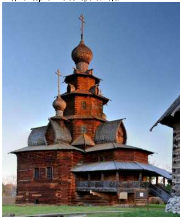
Вид на церковь с северо-запада
