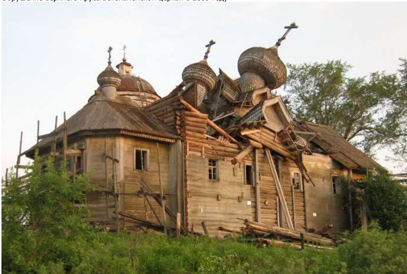
Обрушение верхнего яруса Богоявленской церкви в 2009 году
